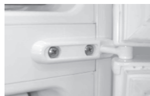
Fig. 2 Central hinge
